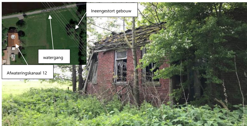
Afbeelding 5.5 Vervallen gebouw, mogelijke vaste verblijfplaats van steenmarter
