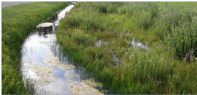
Afvoersloten met natuurvriendelijke oever t.b.v. waterberging. (STOWA)
