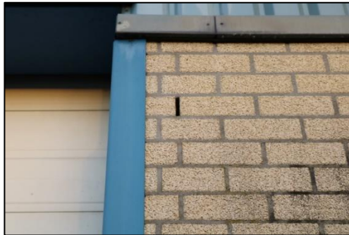
Figuur 4.15. Open stootvoeg hoofdgebouw.
