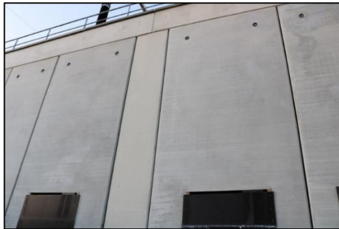
Figuur 4.17. Open kieren bij het gebouw achter
