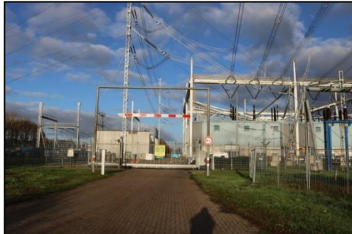
Figuur 4.2. Meest oostelijke ingang.
