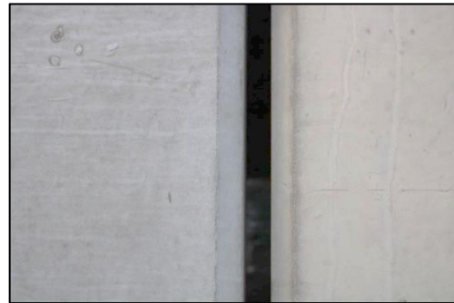
Figuur 4.18. Open kier van dichtbij waarbij toegang tot het gebouw goed te zien is.
