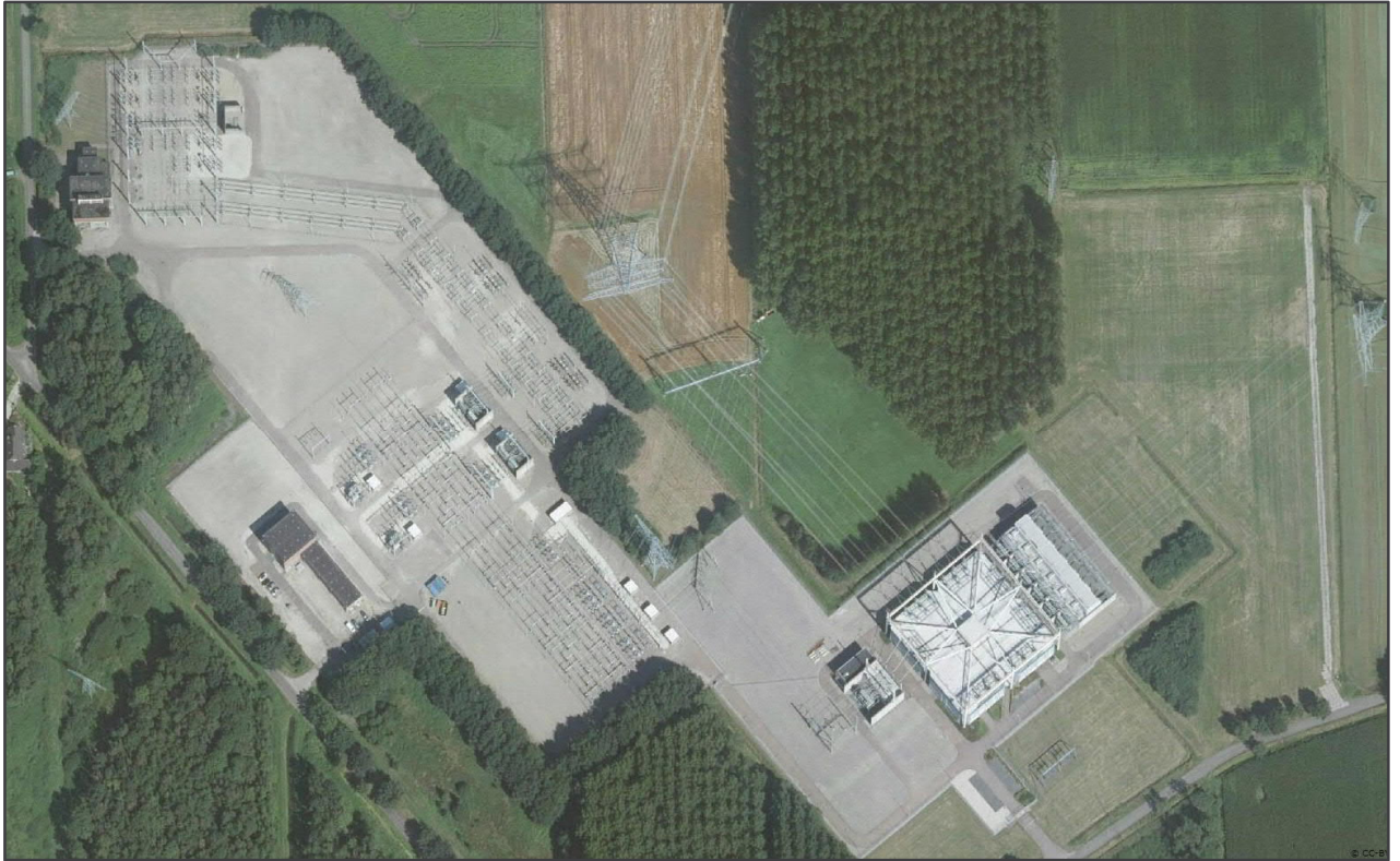
Figuur 1: Luchtfoto van het transformatorstation (Bron: Pdok)
