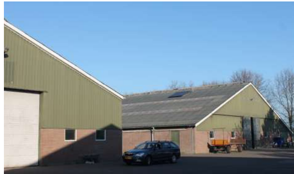
3. stallen op het achtererf
