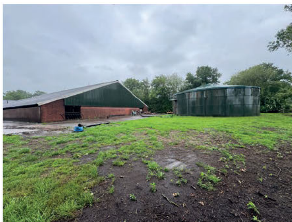
Figuur 12. Opstal 4 en mestsilo gezien vanaf zuidwestzijde.
