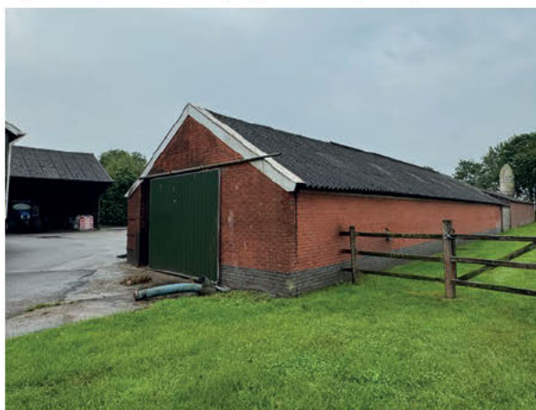
Figuur 4. Opstal 2 buitenzijde, gezien vanaf noordzijde.
