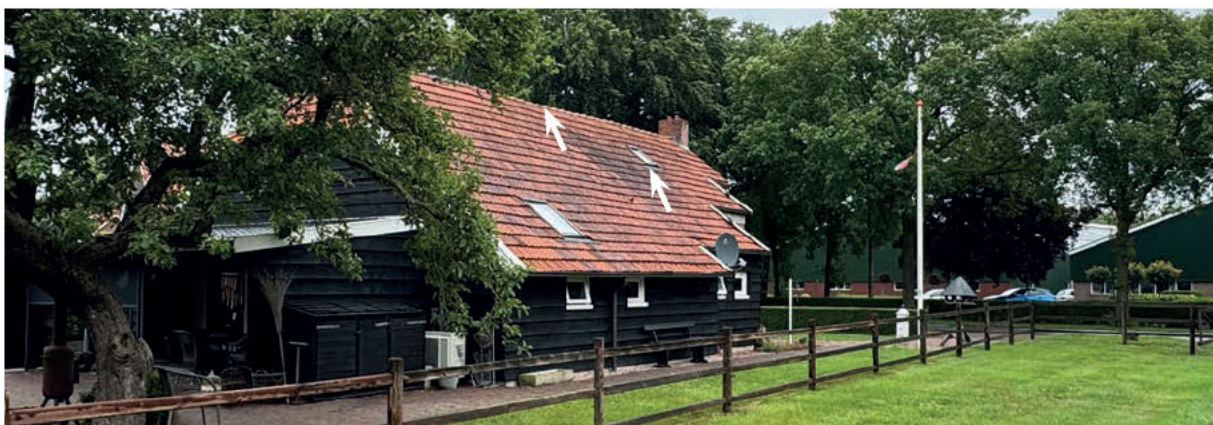
Figuur 22. Invliegopeningen, woning noordzijde.
