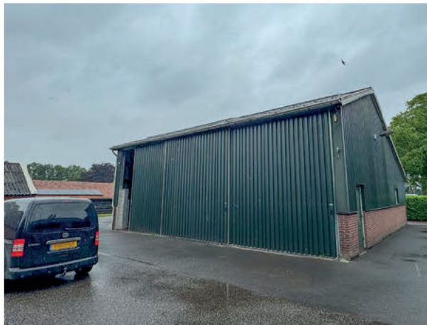
Figuur 2. Opstal 1 buitenzijde, gezien vanaf zuidzijde.
