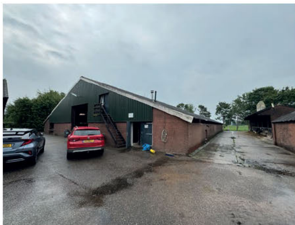
Figuur 8. Opstal 4 buitenzijde, gezien vanaf noordzijde
