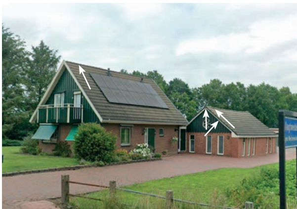
Figuur 12. Invliegopeningen, woning noordzijde.
