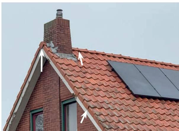
Figuur 11. Invliegopeningen, woning aan de noordzijde.
