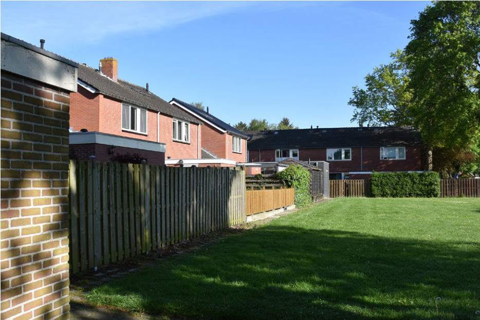
Achtererfgrenzen van woningen langs de Scheper.
