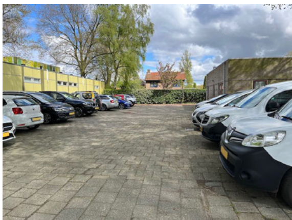
Figuur 6. Oostkant gebouw.
