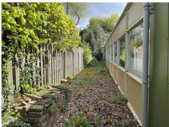
Figuur 4. Noordkant gebouw.
