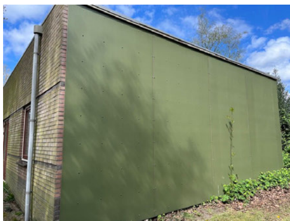
Figuur 5. Oostkant gebouw.
