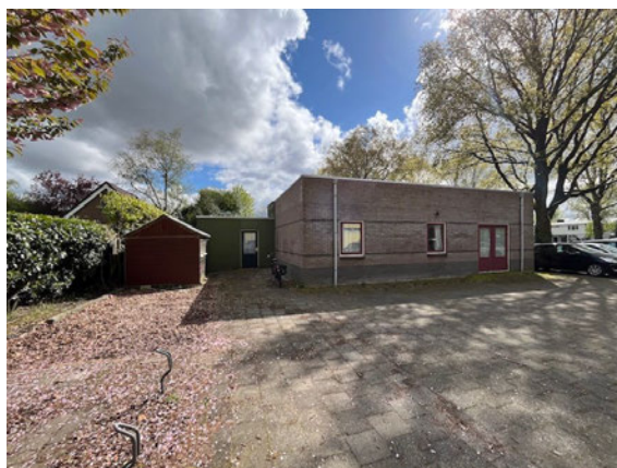
Figuur 3. Westkant gebouw.
