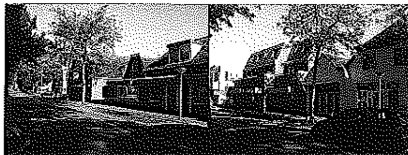
Te verwijderen bebouwing Hoofdstraat
