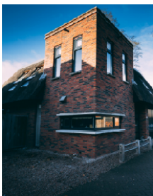
Referentie Moderne detaillering: donkere kozijnen, spekbanden en betonnen kaders
