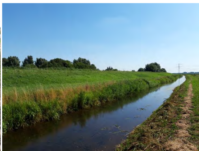
Achterzijde van het plangebied. Ca. 6 meter brede sloot met stijle en gemaaide over aan graanakkerkant. Aan de overzijde is een dijk te zien met struweel met daarachter de Pekel-Aa. Hierover loopt een fietspad. De A7 die weer wachter de Pekel-Aa ligt heeft geen uitzicht op het projectgebied, door de natuur en de dijk die het gebied afschermt.
