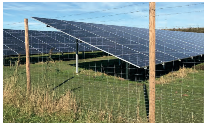
Houten palen met gaas (deer fence) met een vrije ruimte van 20 centimeter aan de onderzijde voor kleine dieren (vrije ruimte niet op de foto)
