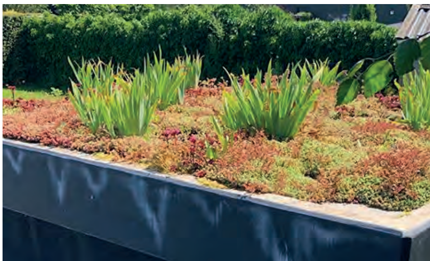
De containers en stations worden voorzien van een groen dak
