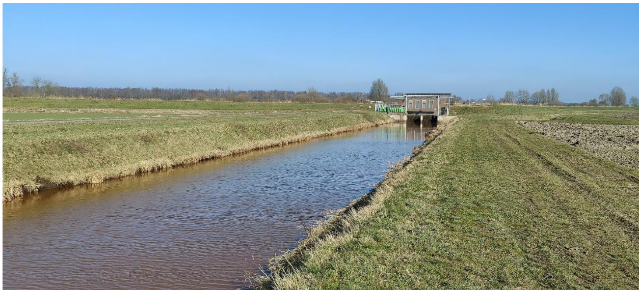
Figuur 2-7: Het Langediep ten westen van het plangebied, met het gemaal ten noordwesten van het plangebied (veldbezoek 2021) (foto: RHDHV).
