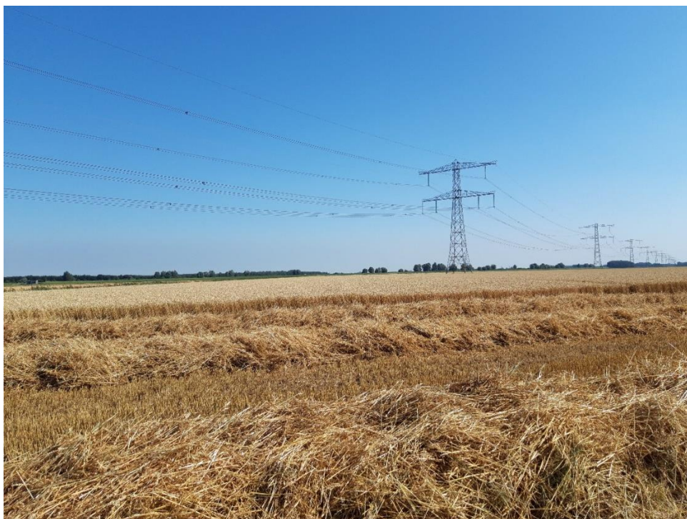
Figuur 2-2: Overzicht over het oostelijke perceel van het plangebied met de hoogspanningsmasten (veldbezoek 2019) (foto: RHDHV).
