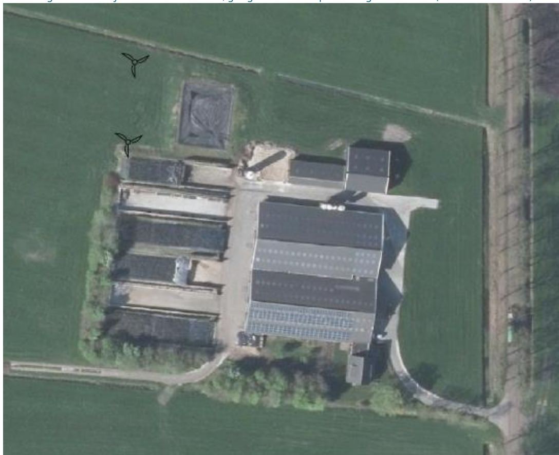
Afbeelding 1.1 Het bedrijf van de familie Aalbers, gelegen aan de Driepoldersweg 2a te Wedde (bron: PDOK services)
