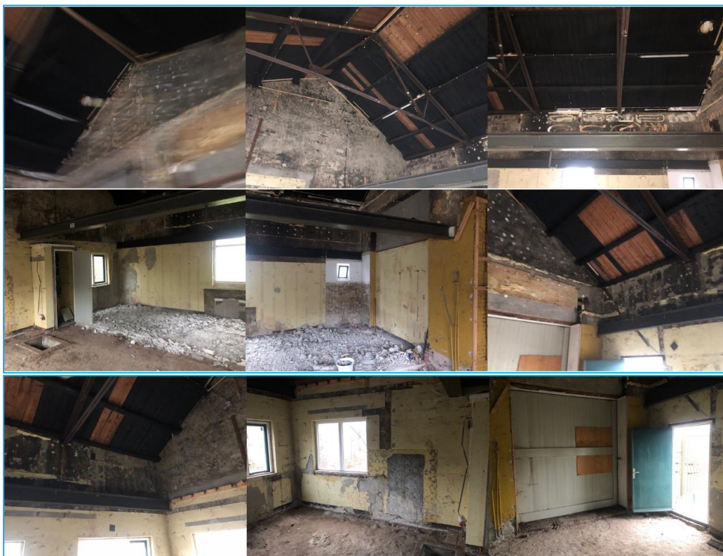
Figuur 4.5 : weergave diverse foto's binnenkant voormalig remisegebouw
