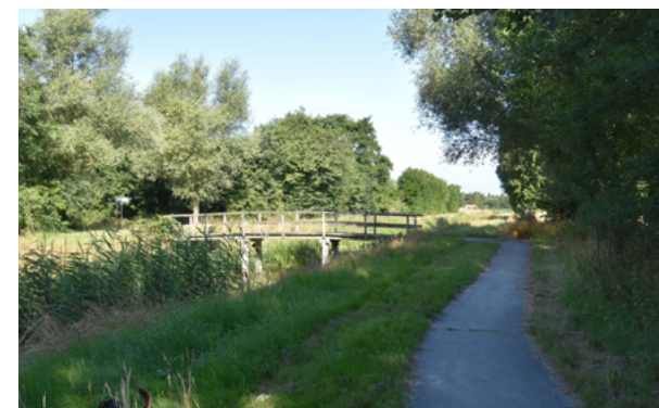
doorgaand fietspad met brug over Veensloot achter perceel 1495
