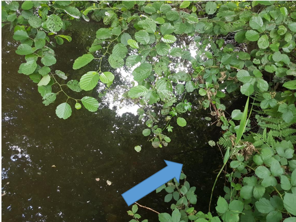
Afbeelding 3: Duiker aan de zijde van het insteekkanaal (slecht te zien). Ook deze is getest met een mast van 4 meter.
