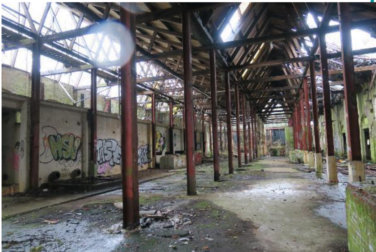
Figuur 5.6 Binnenzijde gebouw H, het dak wordt verwijderd en komt een nieuwe gevel
