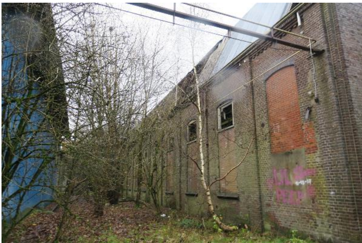
Figuur 5.7 Buitenzijde gebouw H, het dak wordt verwijderd en komt een nieuwe gevel
