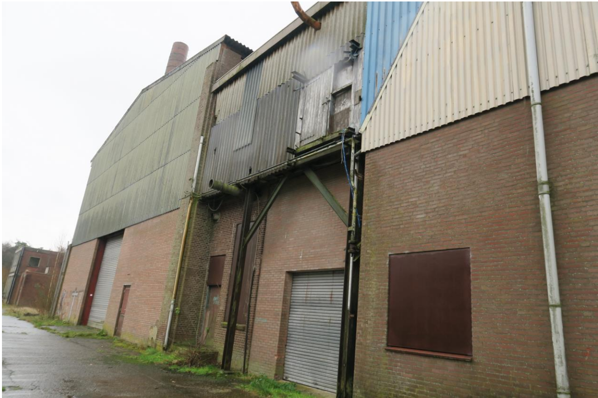
Figuur 5.5 Gebouw F, het bovenste golfplaten deel wordt verwijderd
