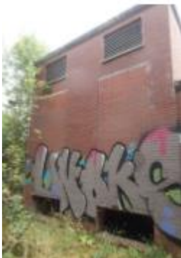
Figuur 5.8 Te slopen gebouw N
