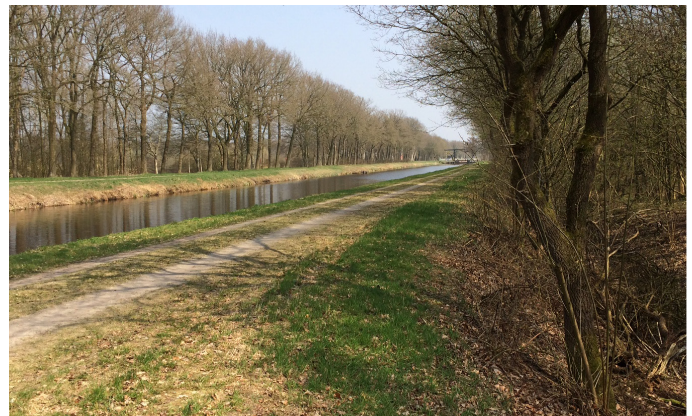
Afbeelding 5. Ruiten A Kanaal Oost VI aan het Ruiten Aakanaal
