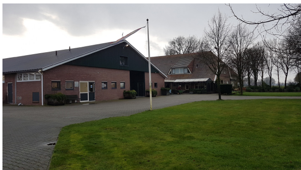
1. bedrijfsgebouwen liggen met kopgevel aan groen voorerf
