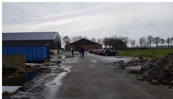
5. achtererfontsluiting met links beoogd te verdubbelen loods
