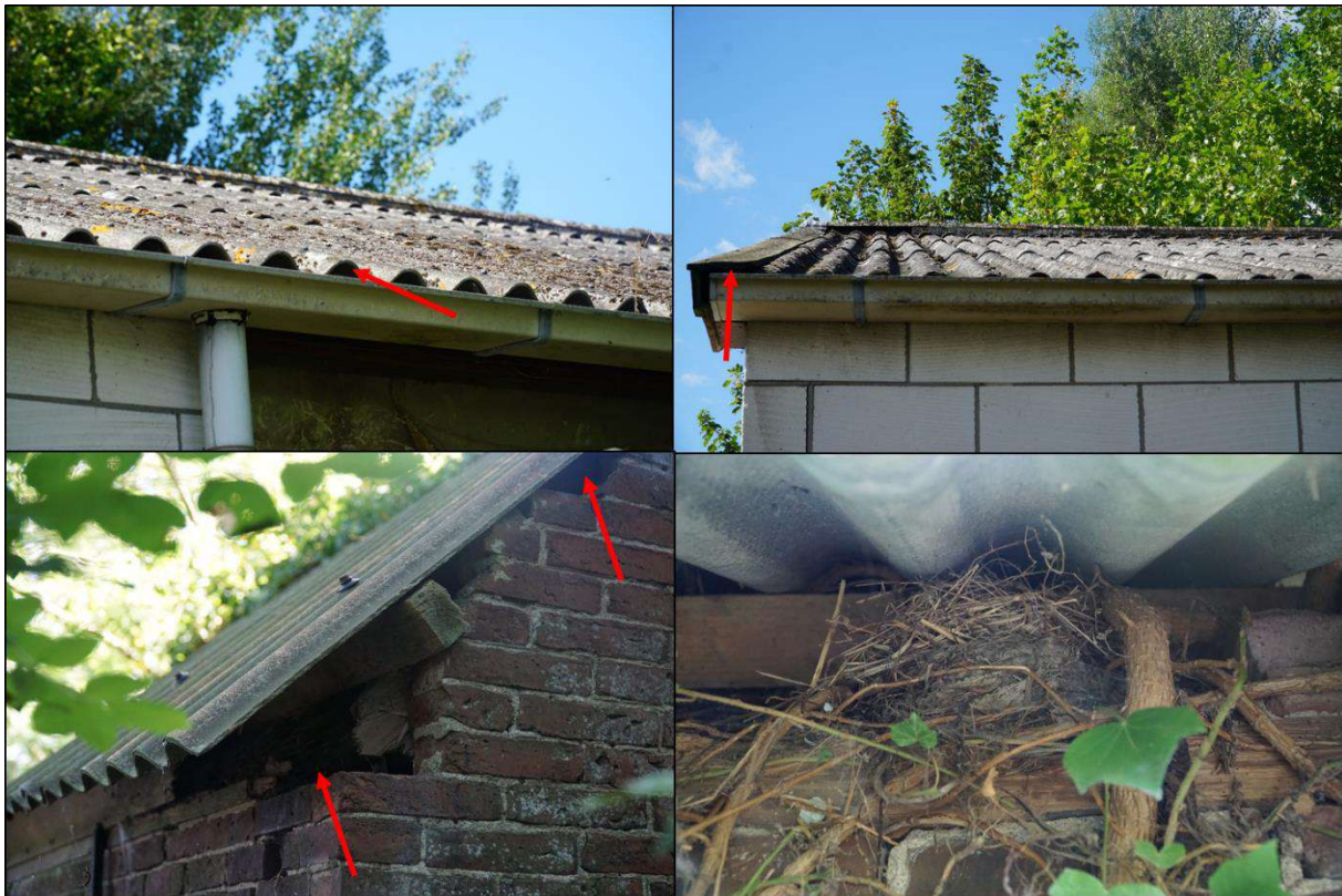
Figuur 2.3. Onder gegolfde dakplaten van de loods en het zuidwestelijk gelegen schuurtje kunnen huismussen tot broeden komen.
