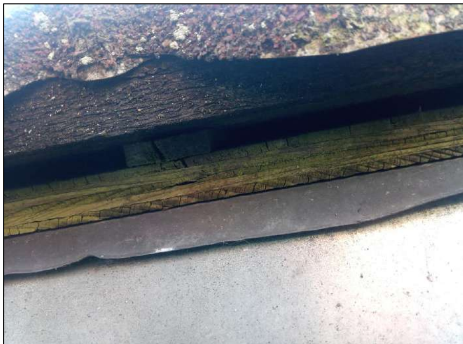
Figuur 2.3. Onder de eerste rij dakpannen van het dak van het schoolgebouw is geen ruimte aanwezig waaronder huismussen en gierzwaluwen tot broeden kunnen komen. Wel kunnen vleermuizen via de kier die zichtbaar is op de foto ruimtes betreden die kunnen dienen als vleermuisverblijfplaats. Foto: Binne Kooistra.
