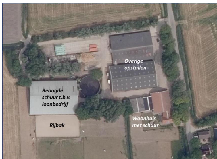
Afbeelding 1: Opstallen aan de Hovensterweg 1 St.-Jacobiparochie
