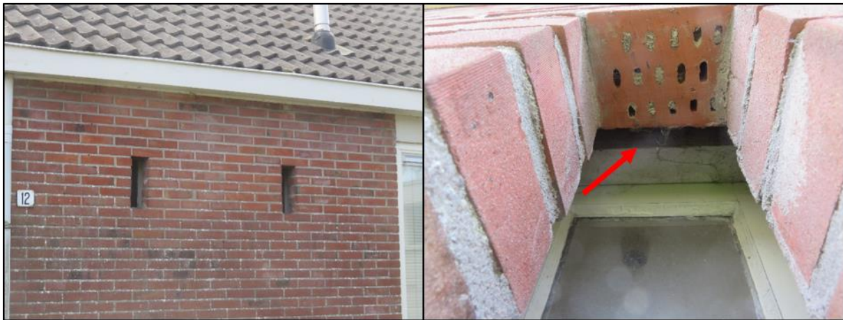
Figuur 2.4. Aan de voorzijde van iedere woningen zijn twee openingen aangetroffen, waardoor de spouwmuur toegankelijk is voor vleermuizen.
