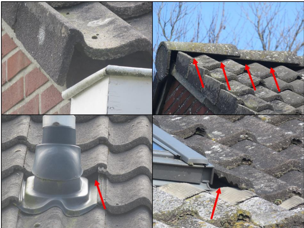
Figuur 2.2. Onder de gegolfde dak- en nokpannen van de 14 woningen zijn voor huismus geschikt bevonden openingen aangetroffen.
