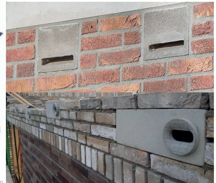
v Ingebouwde vleermuisverblijven (bron: traasnaturecare.nl)
