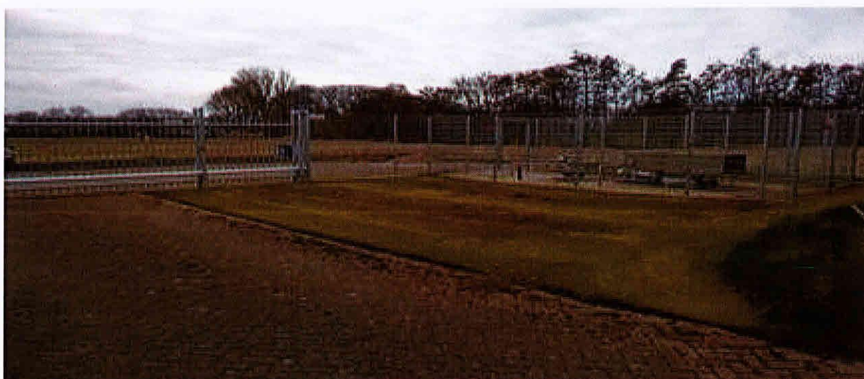
Figuur 2. Ligging LPG reservoir met leidingen. Foto is genomen in noord-oostelijke richting.
