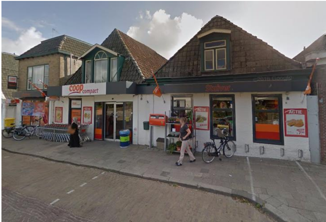
Figuur 5.1 Gevelaanzicht CoopCompact Sexbierum (bron: Google Streetview, augustus 2016)
