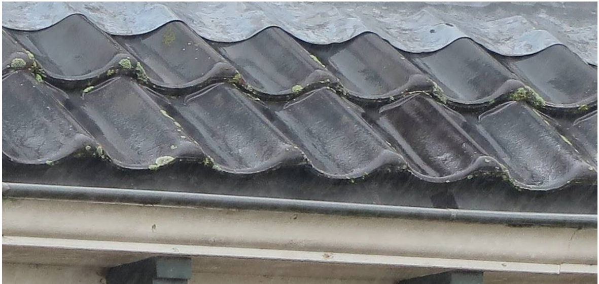
Figuur 3. Dakpannen strak op het dak.
