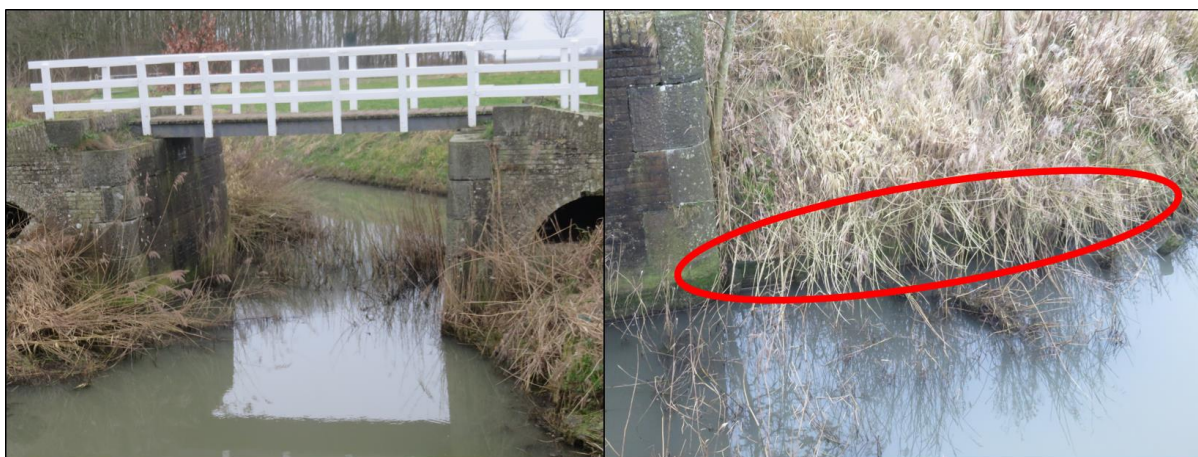
Figuur 2.3. Oeverbegroeiing onder een vlak buiten het plangebied liggende brug (links) en oeverbeschoeiing achter deze brug (rechts).
