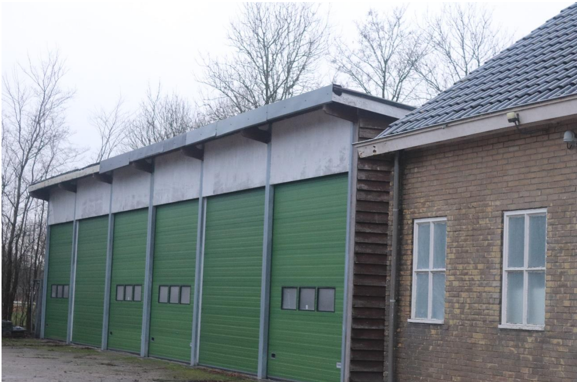
Figuur 3.6: Schuur aan de achterzijde van het kantoor
