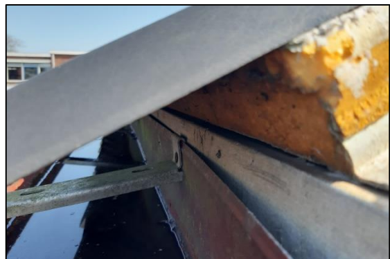
Afbeelding 3.3. Aanwezige pur onder golfplaten.
