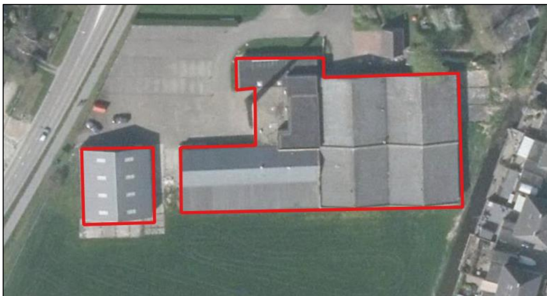
Afbeelding 2.1. Plangebied, alles behalve de stenen schoorsteen zal worden gesloopt. (bron: ESRI)
