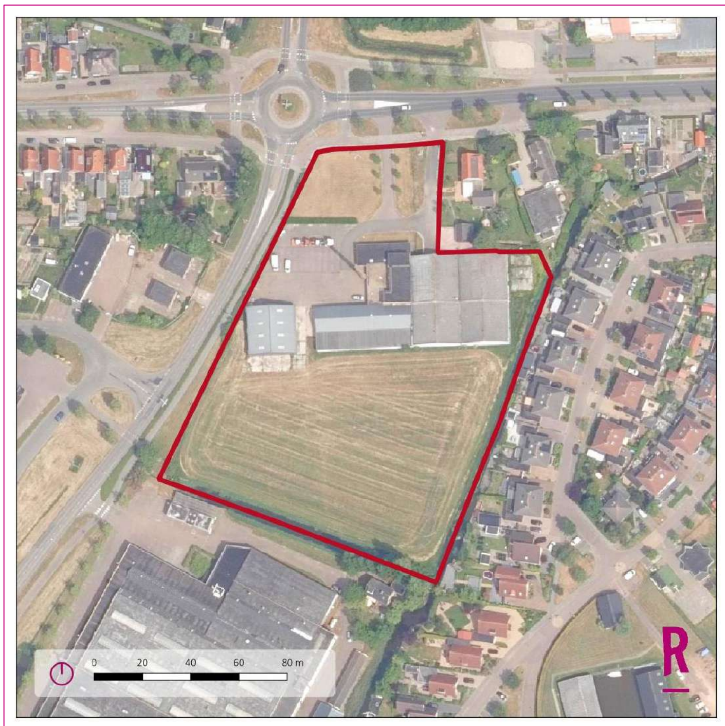
Figuur 2.1: Luchtfoto bestaande situatie
