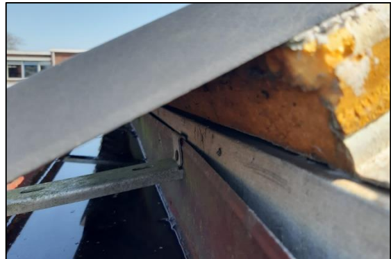
Afbeelding 3.3. Aanwezige pur onder golfplaten.
