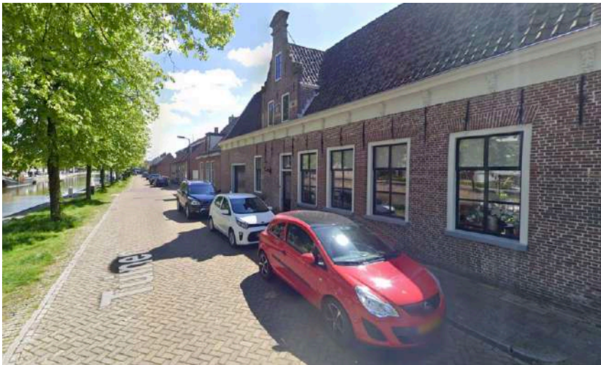
Langs de noordelijke kade wordt er geparkeerd op de weg, veelal aan woningzijde.
