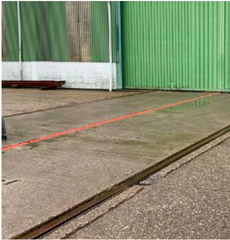
De bestaande stelconplaten worden hergebruikt
