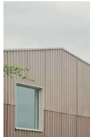
Flauwe dakhelling; dak voorzien van witte dakbedekking, deels afgedekt met zonnepanelen
