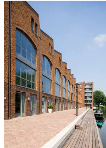
Dakvorm en gevelopbouw met grote boogramen
