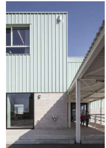
Trasraam ca. 2 meter metselwerk
