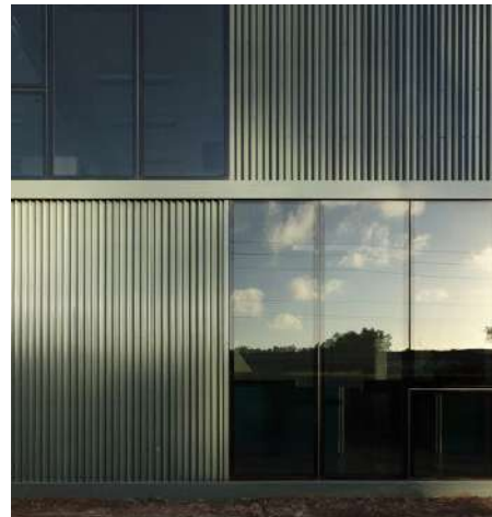
Bovenbouw: metalen gevelbekleding in grid van metalen constructieonderdelen
