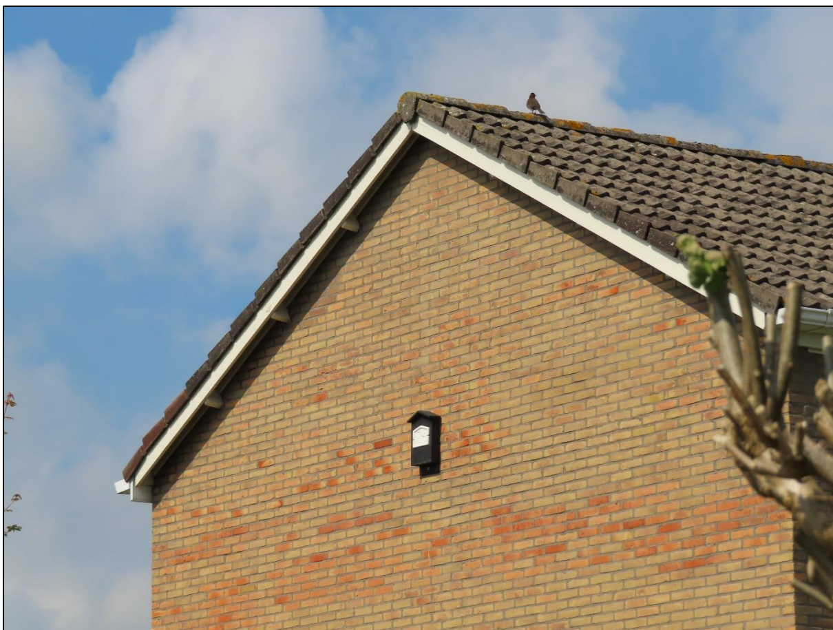
Figuur 2.2. alternatieve nestgelegenheid voor de huiszwaluw onder een overhangende daklijst van een woning in de omgeving van het plangebied.
