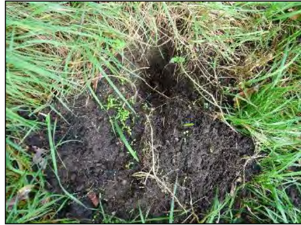
Figuur 15. Snuitputje langs de wissel op de noordoostzijde van de onderzoekslocatie.
