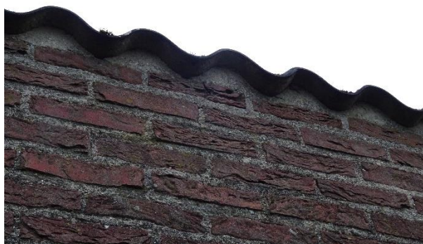
Afbeelding 9 t/m 11: Aangrenzende bomen en bebouwingen gecontroleerd op de mogelijke aanwezigheid van vleermuizen. Bron: BNL advies. Datum: 18-01-2022
