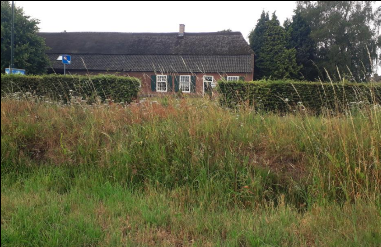
Figuur 7: Duidelijke steilrand tussen het meest westelijke deel van het plangebied en het hoger gelegen deel met de weg (Pastoor Clercxstraat) en historische bebouwing (juli 2019).
