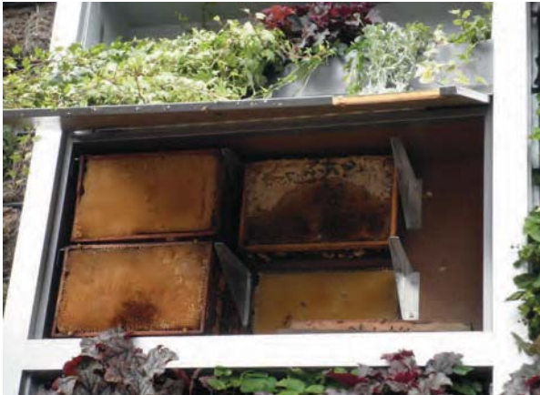
bijenkasten verwerkt in gevel
