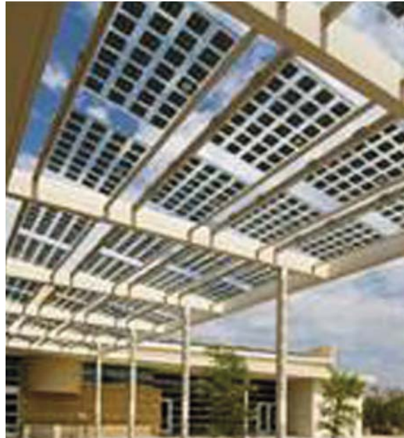
zonnecellen verwerkt in dak
