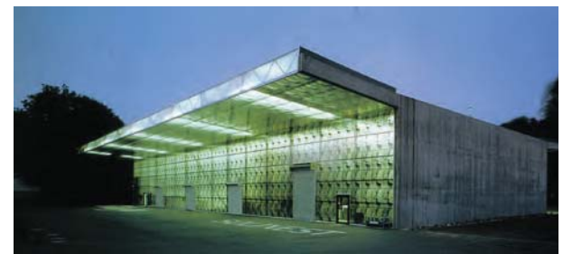
referentiebeeld verlichting totale gebouw
