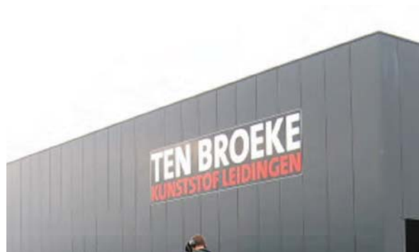
referentiebeeld reclame op gevel
