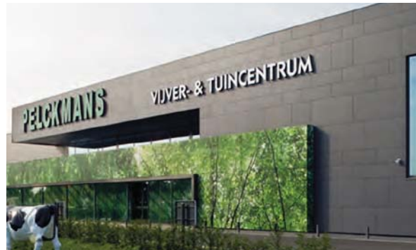
referentiebeeld reclame op gevel
