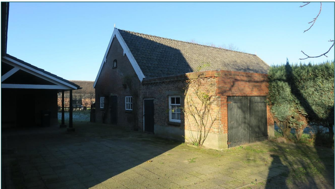
Figuur 4 De te slopen aanbouw betreft één bouwlaag en heeft een plat dak.
