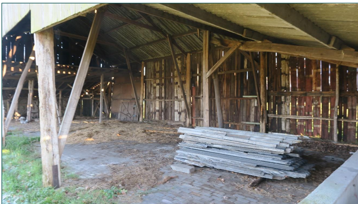
Figuur 2 De kapschuur is opgetrokken uit houten wanden met een golfplaten dak.
