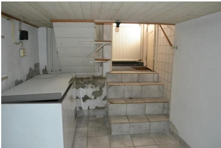
Kelder onder opkamer.
