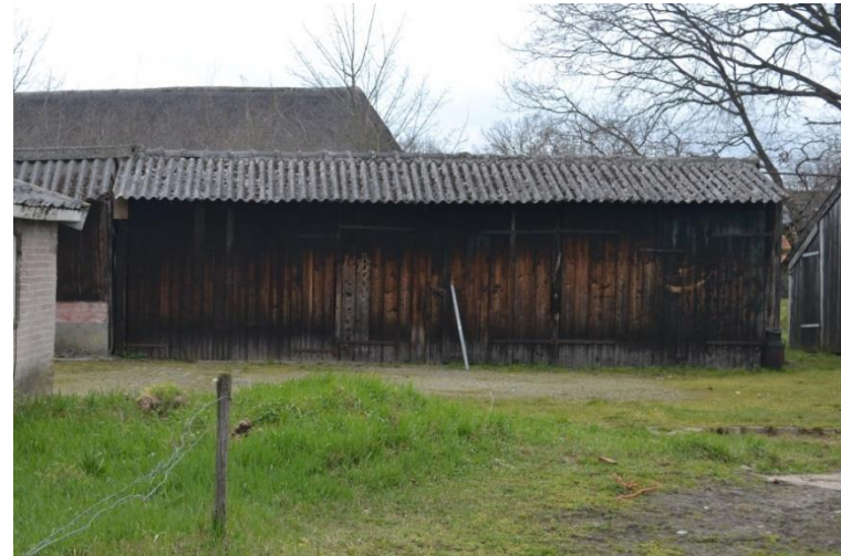
Schuur op perceel.
