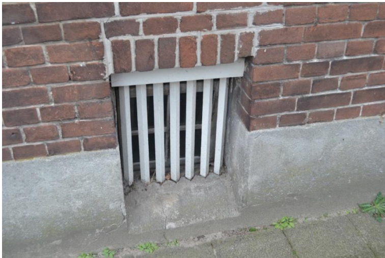
Kelderraam met diefijzers.
