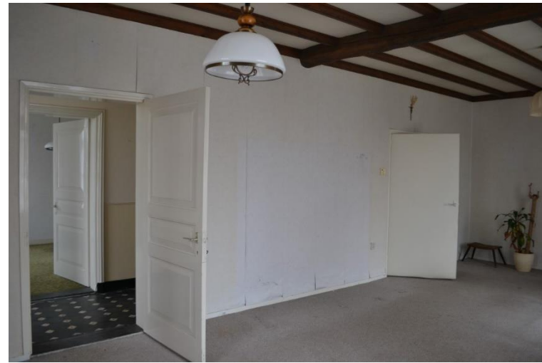
Zicht op woonkamer richting gang.
