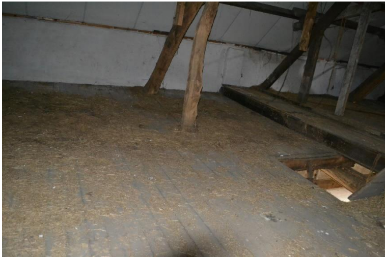
Bovenzijde verdiepingsvloer met luik.
