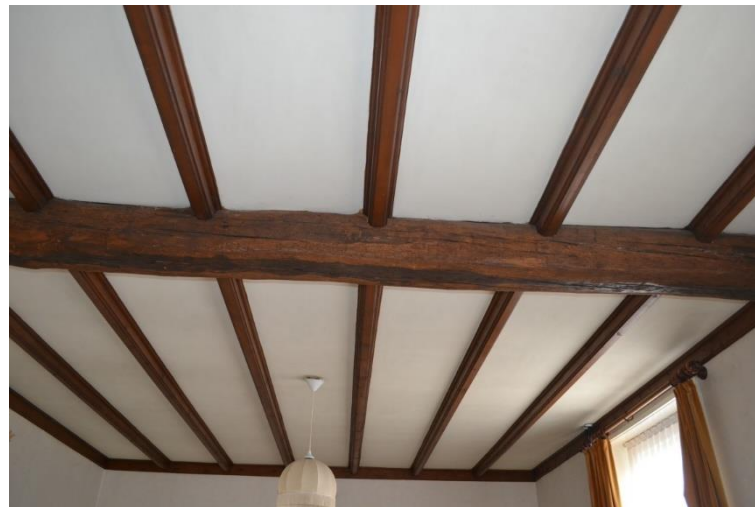
Vernieuwd plafond in vergrote woonkamer.
