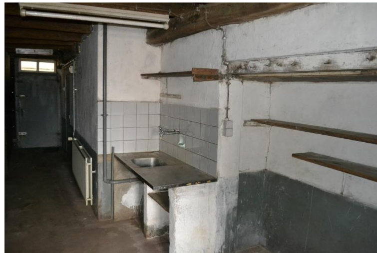
Gootsteen in ganggedeelte.
