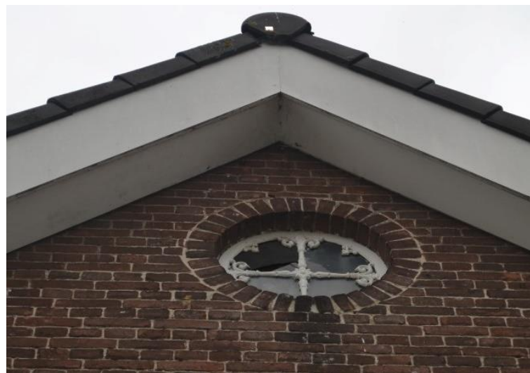
Gietijzeren rondlicht in topgevel.
