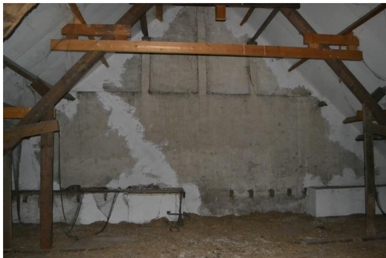
Brandmuur vanuit hooizolder.
