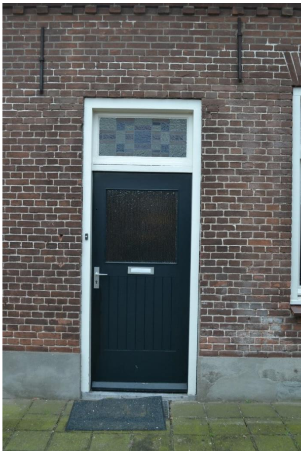
Later aangebrachte achterdeur.
