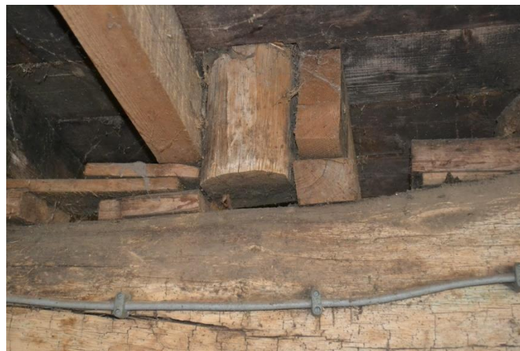
Afgezaagde staanders door verdiepingsvloer.
