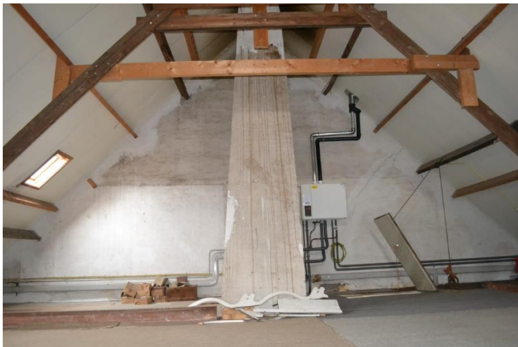
Brandmuur en schoorsteen op verdieping.
