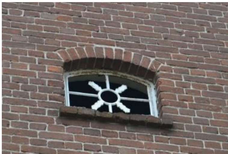
Stalen stalraam met spinnenkop
