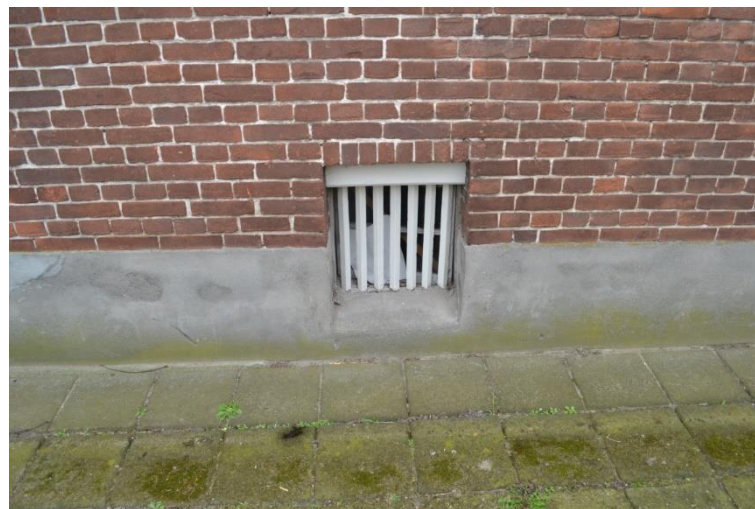
Kelderraam met diefijzers.
