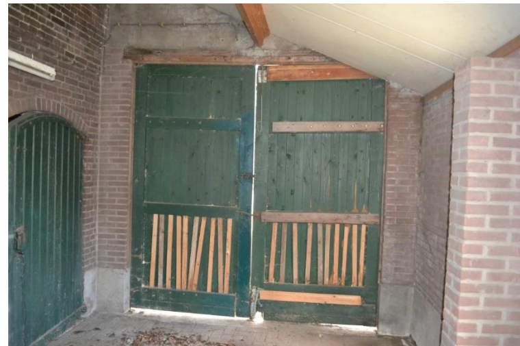
Latere aanbouw aan achterzijde.
