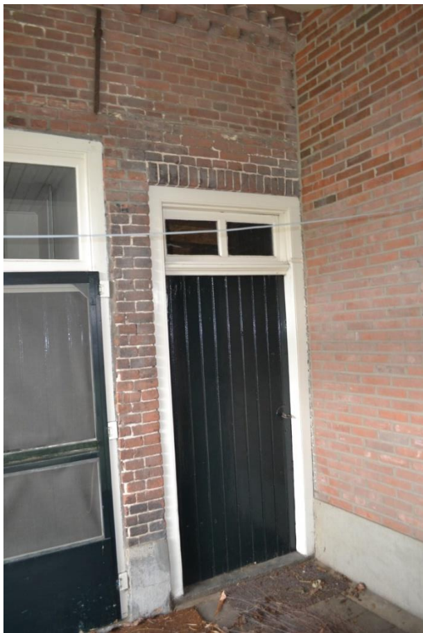
Houten kozijn met loopdeur, vermoedelijk uit de bouwtijd.
