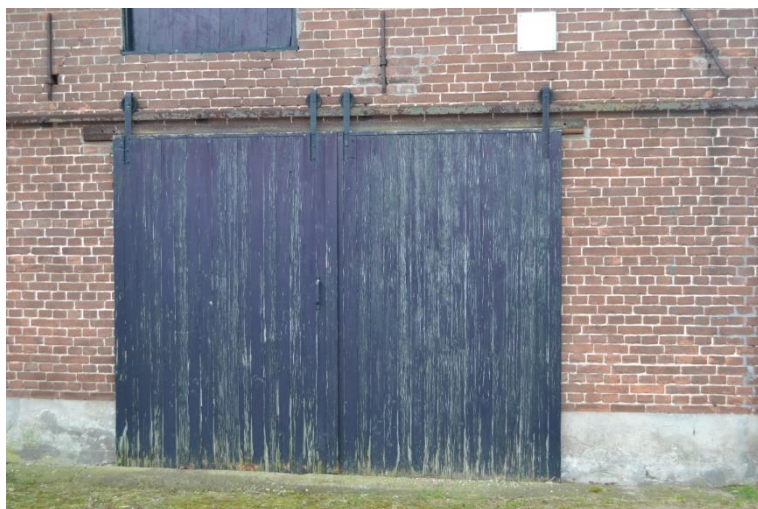
Houten deuren in schuifstelsel.
