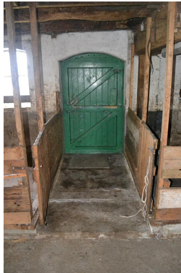
Deur naar later aanbouw aan de achterzijde.
