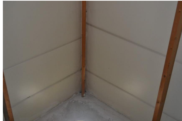
Vernieuwde (geïsoleerde) dakplaat.
