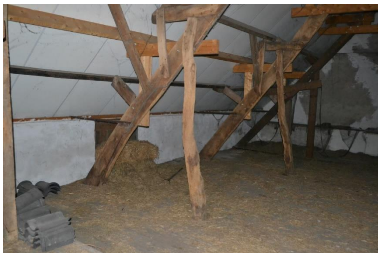
Later aangebracht luiken op de hooizolder.
