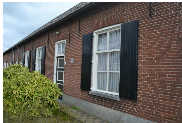
Drie vensters met schuiframen en voordeur met bovenlicht.
