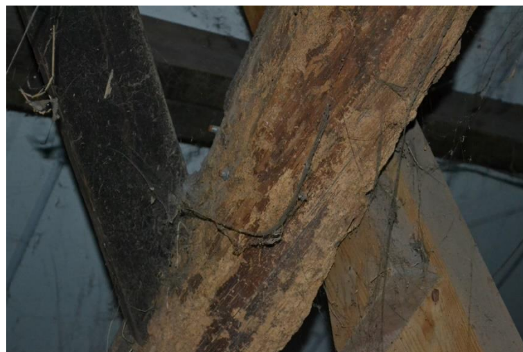
Nieuwe koppelingen in spantconstructie.
