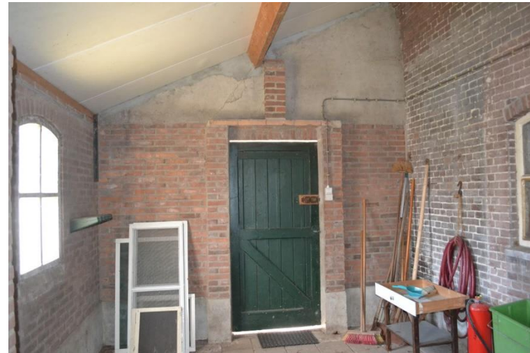
Latere aanbouw aan achterzijde.
