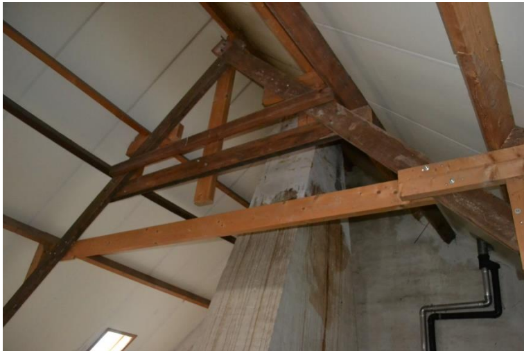
Vernieuwde spantconstructie.
