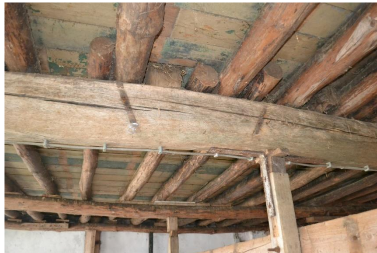
Onderzijde verdiepingsvloer met rondhouten verdiepingsvloer.
