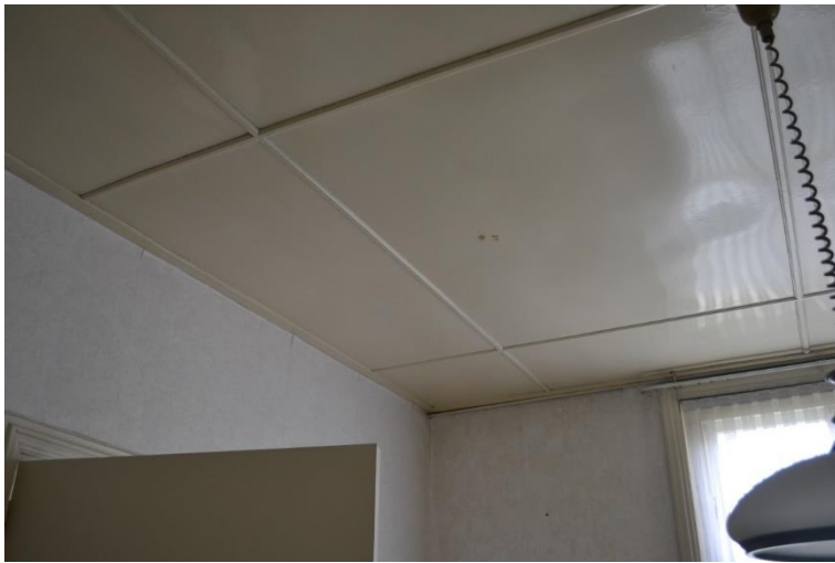
Zachtboard plafond in eetkamer en kleine kamer
