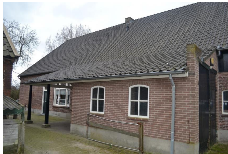
Latere luifel met aanbouw in achtergevel, links het woongedeelte.
