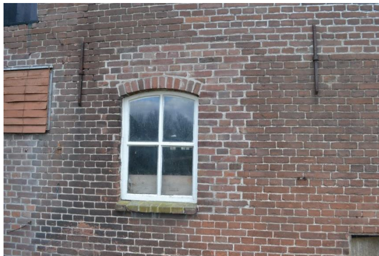
Betonnen stalvenster.
