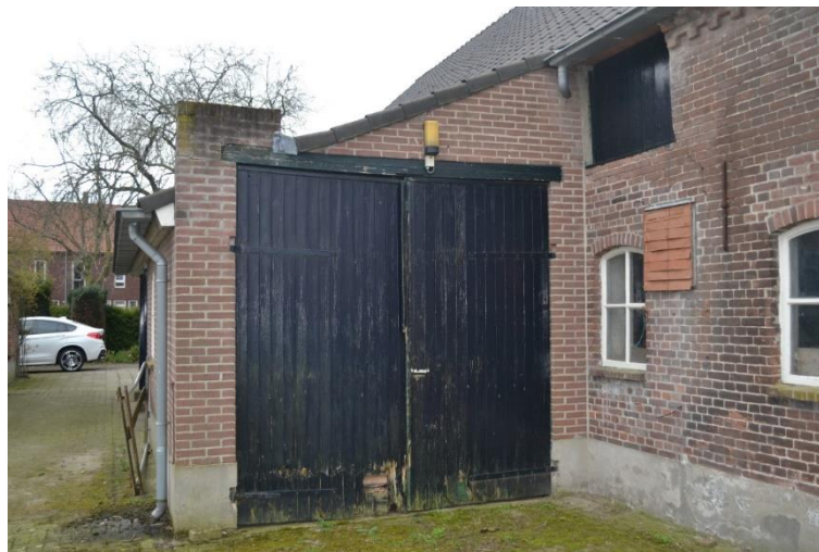
Houten dubbele deeldeuren in zijgevel aanbouw.
