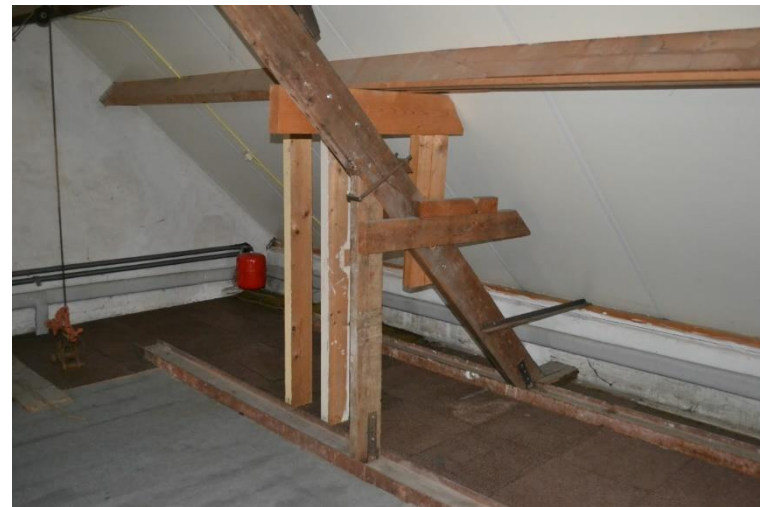
Oorspronkelijk spantbeen met latere versteviging.
