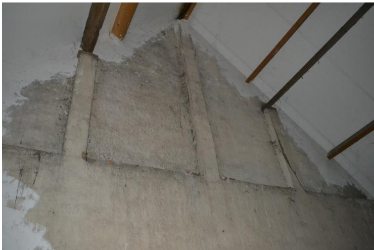
Geledingen in brandmuur ten behoeve van opleggen constructie.
