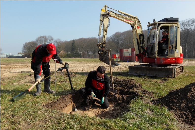
Figuur 3. Benaderen objecten m.b.v. beveiligde graafmachine.
