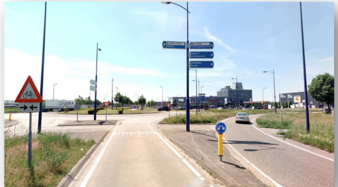
Afbeelding 1 De bestaande rotonde Corridor - Eerdsebaan - Corsica
