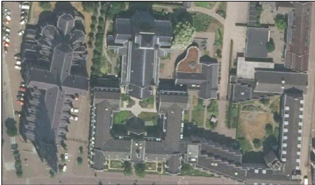
Figuur 9. Bestaande bebouwing locatie Klooster Franciscanessen
