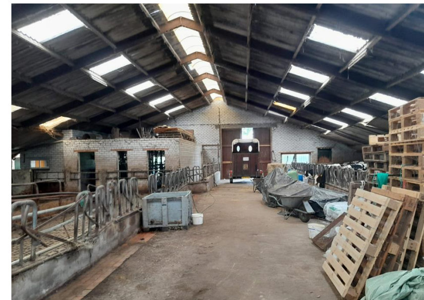
Figuur 7: Binnenkant van zuidelijke ligboxenstal
