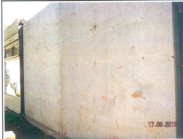
Foto 6. Hier is vlakke plaat verwijderd achterzijde van de school.
