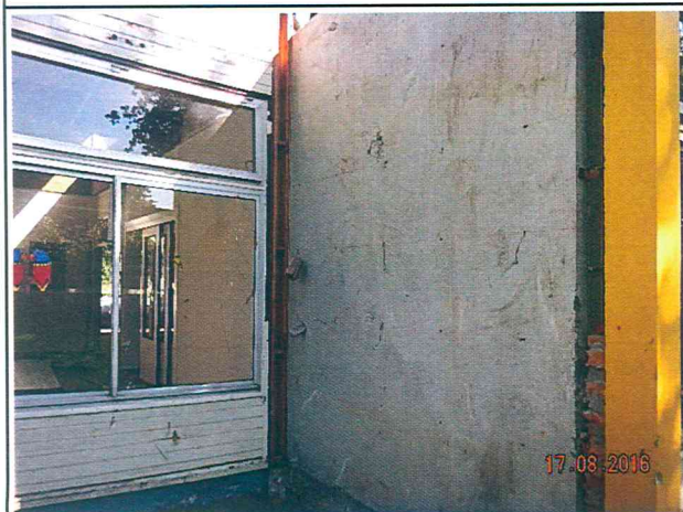
Foto 3. Hier is vlakke plaat verwijderd links van de school.
