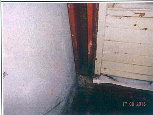
Foto 8. Hier is vlakke plaat verwijderd aan de achter zijde van de school
