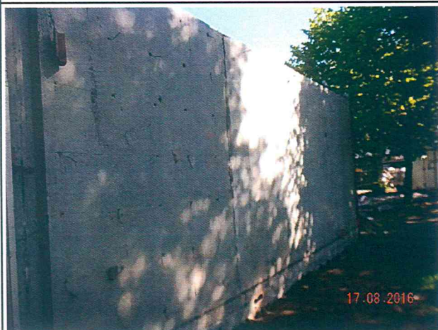
Foto 2. Hier is vlakke plaat verwijderd links van de school.
