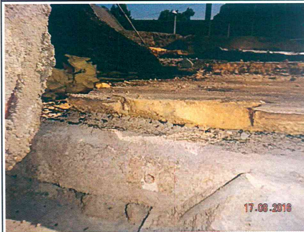
Foto 5. Inspectie op het plat dak.
