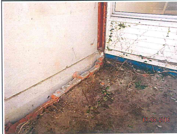
Foto 7. Hier is vlakke plaat verwijderd aan de voorzijde van de school
