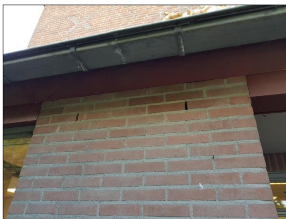
Figuur 10. Open stootvoegen
