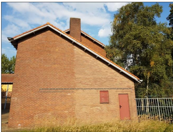
Figuur 7. Zuidzijde van complex
