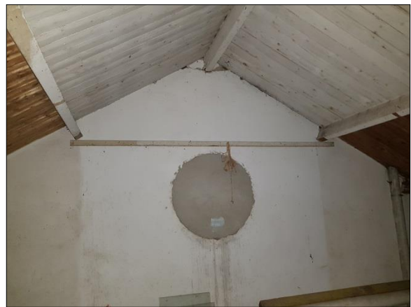
Figuur 8. Binnenzijde nok complex
