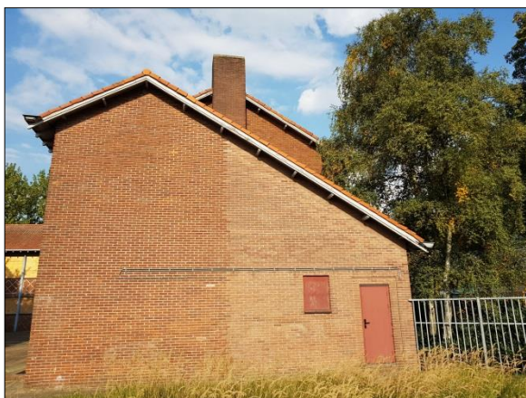
Figuur 7. Zuidzijde van complex
