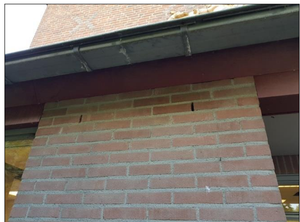
Figuur 10. Open stootvoegen
