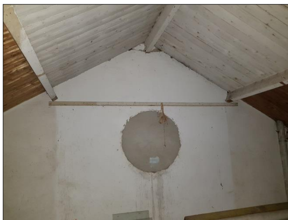
Figuur 8. Binnenzijde nok complex
