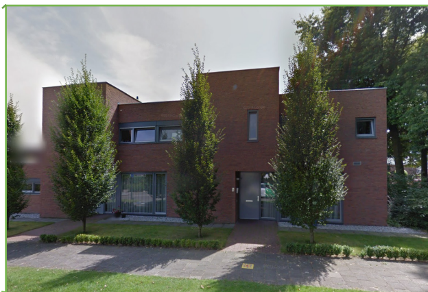
Woningen hoek Spoorlaan - Koolenkampenstraat
